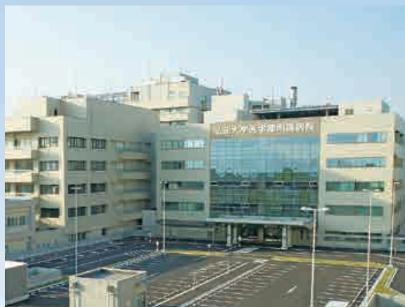
病院外観正面
